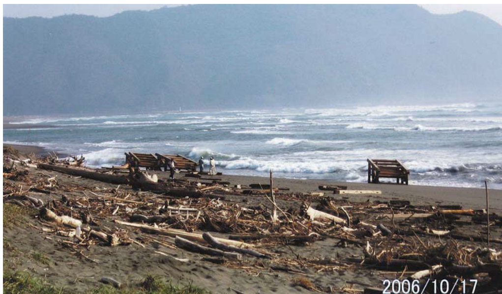
装置の被災状況 【2006.10.17】
