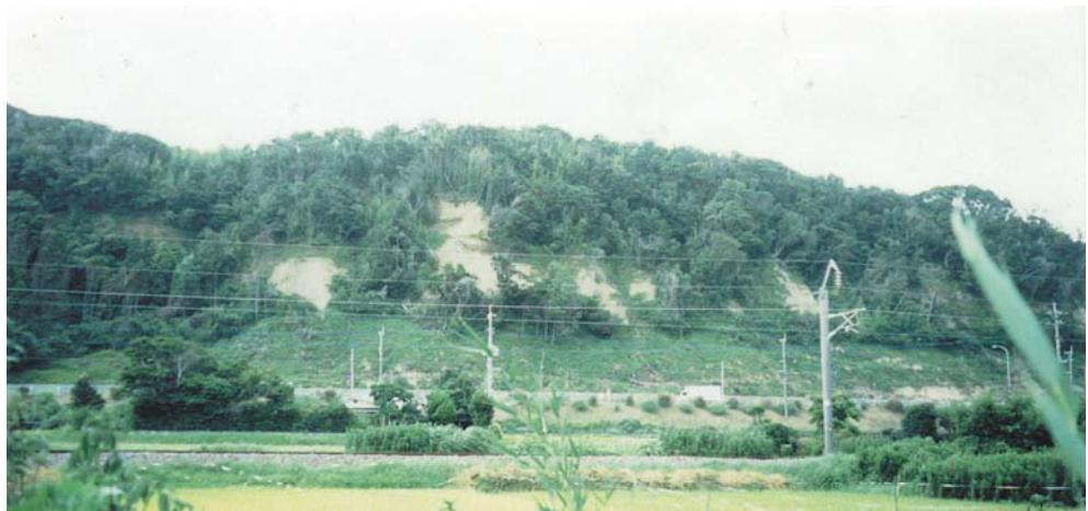
写真－2 潮害防備保安林が消失して崩壊する法面
